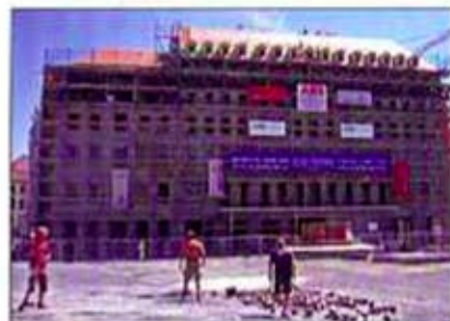
Der Betonskelettbau-Rohbau mit Ortbeton-auskleidungen
