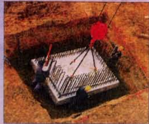
Im Sommer 2008 soll die Spitze vom „Quartier III“ auf den Neumarkt ragen (gr.F.). Für das neue „Juwel an der Frauenkirche“ wird derzeit das Fundament gebaut (F.o.). Neben der Baugrube lässt Privatinvestor Peter Zeibig zwei Bürgerhäuser entstehen, die Wohnungen und ein „Augustiner Brauhaus“ beherbergen sollen (F.l.). Fotos/Grafik: Arnold, PR
