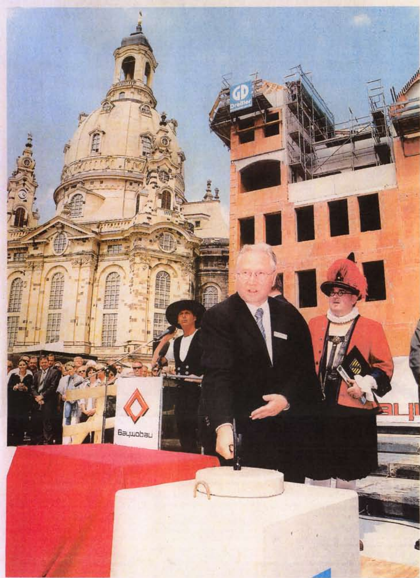
Mit einem symbolischen Hammerschlag versenkt Baywobau-Dresden-Chef Berndt Dietze die Schatulle mit Bauplänen, Tageszeitungen und aktuellem Geld im Grundstein für die Häuser an der Spitze des Quartiers III (siehe Grafik). Fotos (2): Dietrich Flechtner
