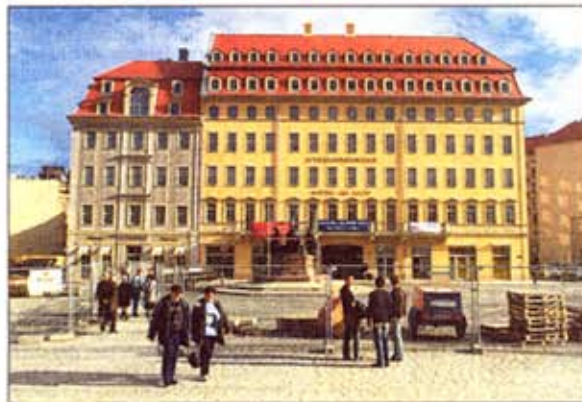
Letzte Pflasterarbeiten vor dem Hotel de Saxe mit der Salomonis-Apotheke.
