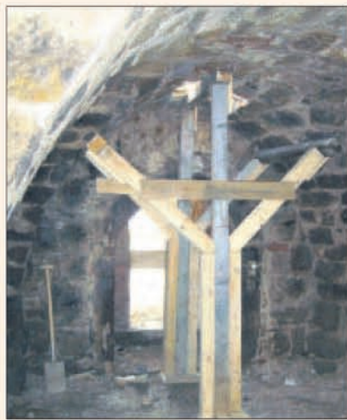
Der freigelegte gotische Bogen eines Kreuzgratgewölbes aus dem 15. Jahrhundert wird im Hotelkeller integriert.
