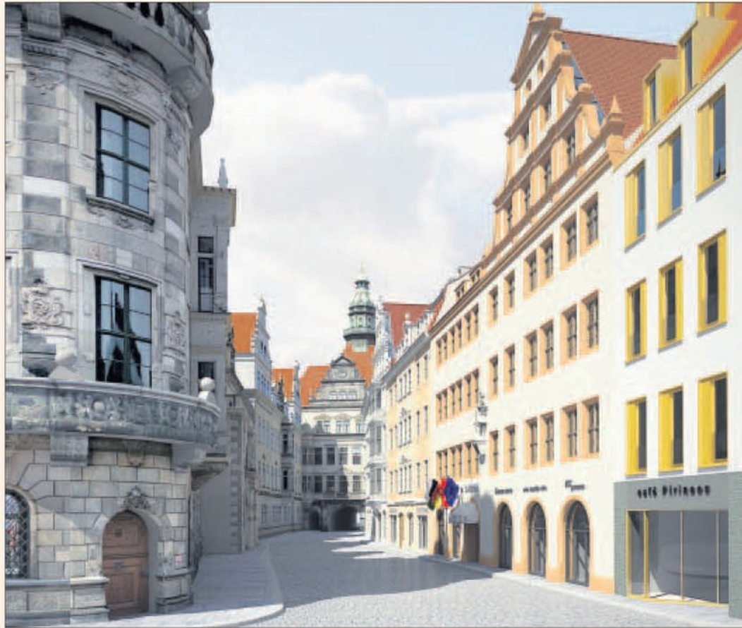
Das Schlosshotel Swissôtel wird an der zum Georgentor führenden Schlossstraße gegenüber dem Residenzschloss errichtet.
