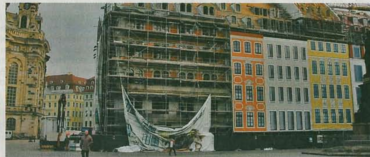
Wenn die Hüllen fallen, kann man bereits die künftige Struktur der Fassaden erkennen. Foto: H. Schuster
