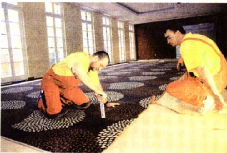
Hubertus Preißner und Sebastian Bartsch von der Oelsnitzer Firma Preisung verlegen den Teppich im Restaurant. Fotos (2), Dietrich Flechtner
